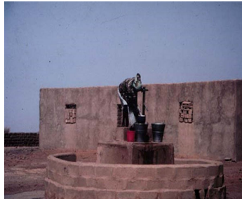
Figure 9 : Puits à margelle fermée
